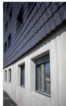
Au total, 3.500 m<sup>2</sup> de tuiles terre cuite Diamant Huguenot ont été posées, à raison de 1.800 m<sup>2</sup> en toiture (avec une pente de 45%) et 1.700 m<sup>2</sup> en bardage rapporté, ainsi que 900 tuiles Solaire Max 16 cellules soit une surface de 370 m<sup>2</sup> pour une production énergétique optimale de 75 Wc par tuile soit 67.500 Wc.
