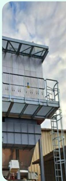
No primeiro trimestre de 2024, a unidade de Phalempin investiu num purificador de nova geração para a limpeza dos fumos do forno. Com uma purificação melhorada, o calor residual desses fumos pode agora ser recuperado para a secagem das telhas, permitindo assim compensar o elevado consumo de gás do secador. No total, isto significa uma poupança de 900 toneladas de CO<sub>2</sub> por ano, bem como uma redução significativa das nossas emissões de dióxido de enxofre.
