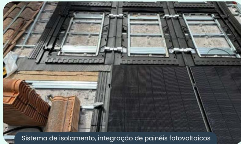
Sistema de isolamento, integração de painéis fotovoltaicos
