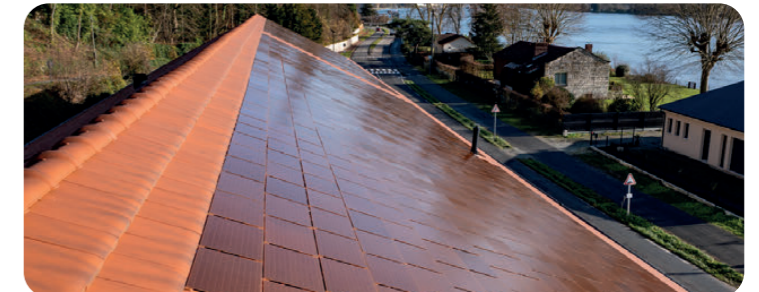
> Versant de la toiture orienté plein sud
