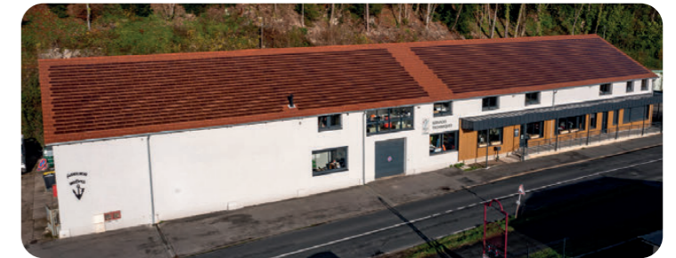
> Vue d'ensemble du bâtiment des Services Techniques
