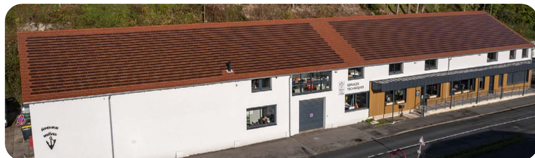
> Panoramica dell'edificio dei servizi tecnici
