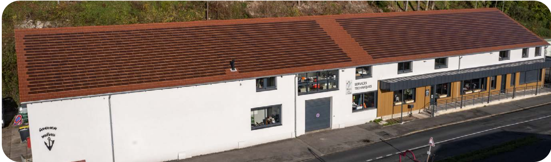
> Vista geral do edifício dos Serviços Técnicos
