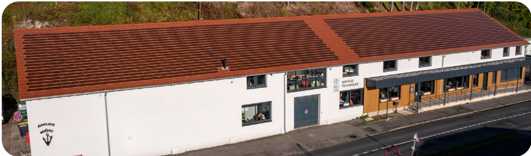
> Vue d'ensemble du bâtiment des services techniques
